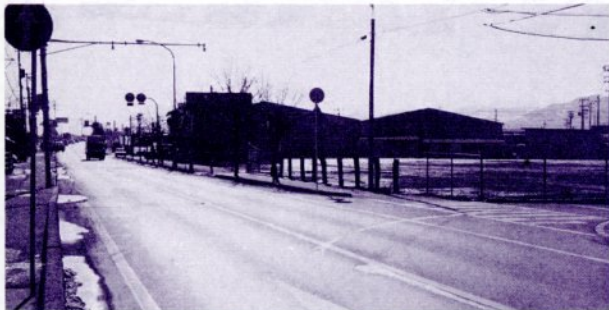
国道53号の拡幅が要望されている消防庁舎建設予定地付近(吉成地内)
