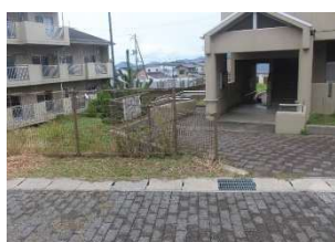
⑱ フェンス
