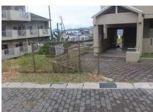
⑱フェンス
