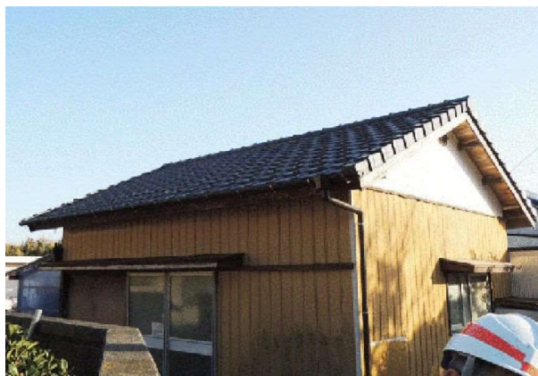
ガイドライン工法の瓦屋根（ほとんど被害なし）
