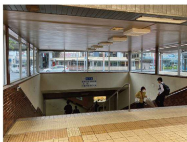
バリアフリーが未対応の 地下通路
