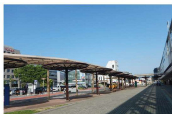
送迎、タクシー、駐車など 自動車を中心の南口広場
