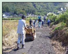
未舗装農道の舗装
