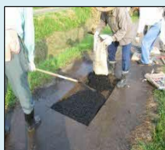
農道の部分補修
