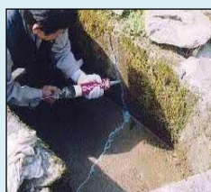
ひび割れの補修
