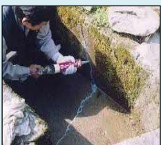
ひび割れの補修
