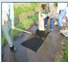
農道の部分補修
