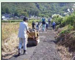
未舗装農道の舗装
