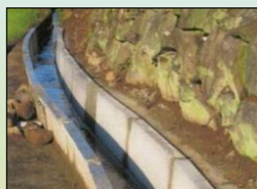
素堀り水路からの更新
