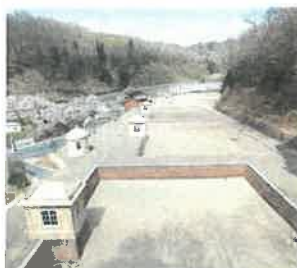
旧美敷水源地下水道施設
