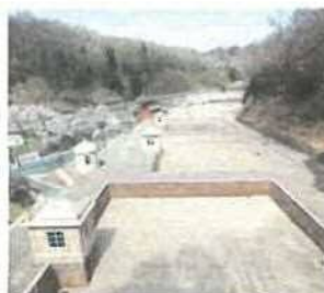
旧美敷水源地下水道施設
