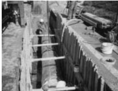
老朽管の取り替えに併せて、耐震性に優れた水道管へ取り替えています。
