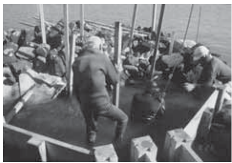
「三津地区石がま保存会」による 田中善蔵家 石がま改修風景 (平成18年8月)
