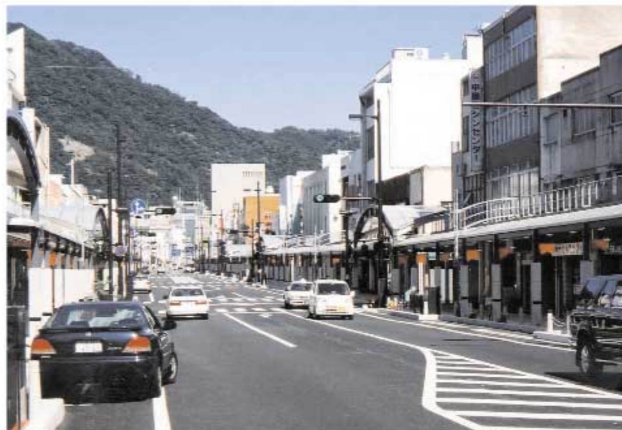
連続するアーケード街（JR鳥取駅北口～市役所）
