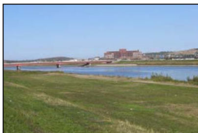
■千代川河口付近の状況
