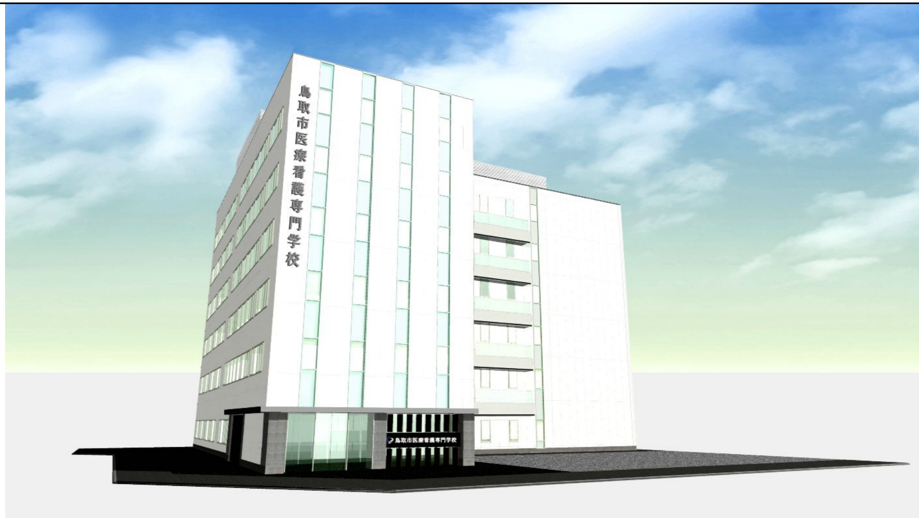
北西より見る
