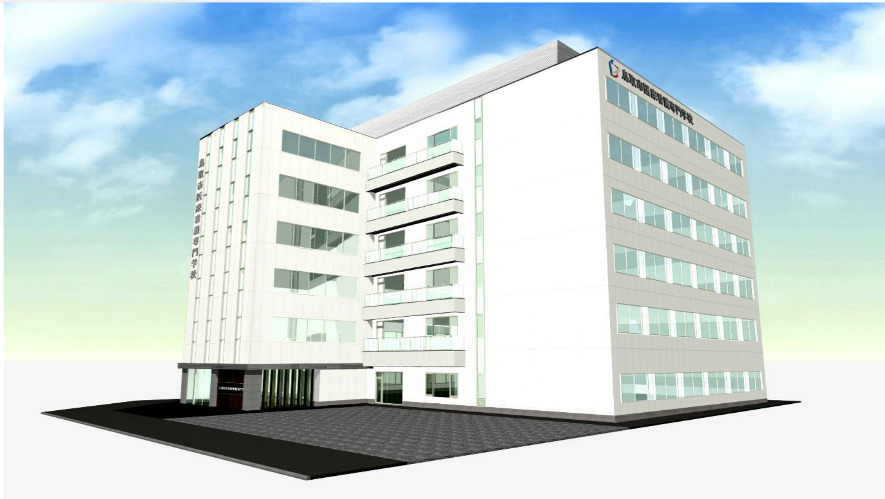
北東より見る
