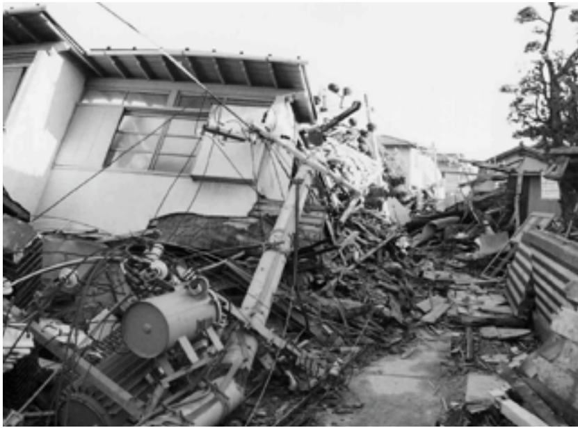
阪神・淡路大震災での被災状況写真 (阪神・淡路大震災記念 人と未来防災センター提供)
