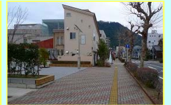
歩道美化 電線類地中化
