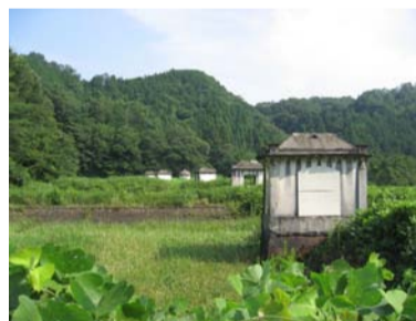
1号濾過池北側から見た濾過施設
