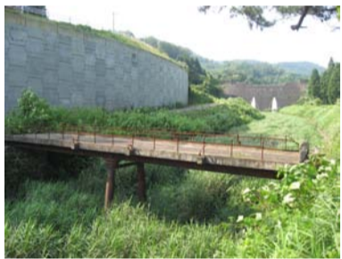
人道橋と堰堤遠景
