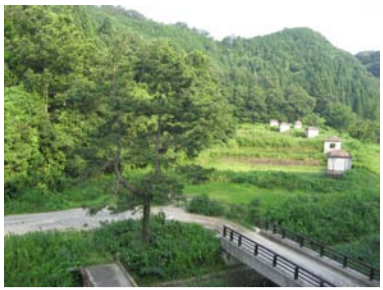
広域農道からみた濾過施設
