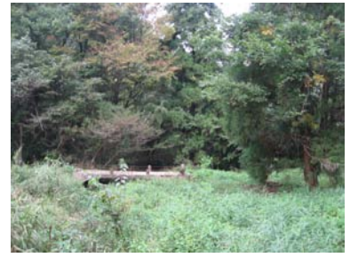
勝田ヶ平人道橋
