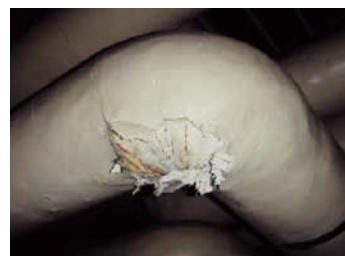
配管エルボの保温材
