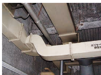
機械室の吹付け材
