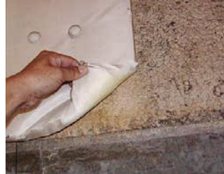
グラスウール貼りの裏の吹付け材
