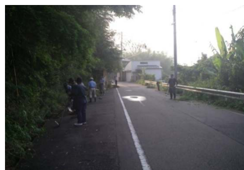
市道の除草作業
