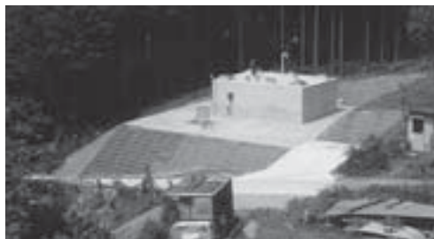
計画的な整備が図られている簡易水道施設
