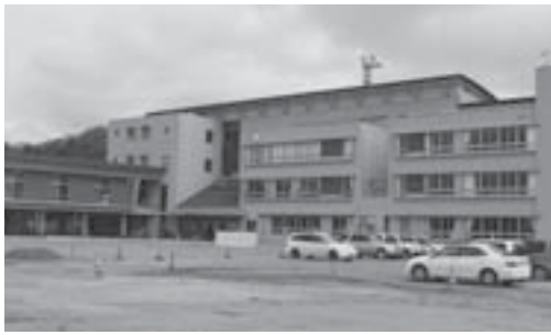
新しい耐震基準に沿った改築工事が行われた城北小学校の校舎
