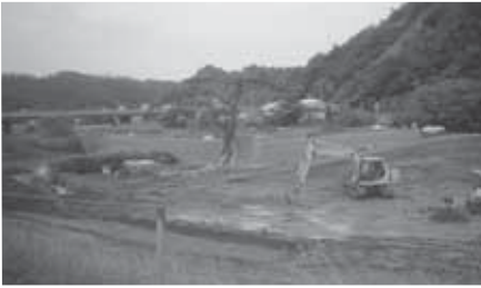
整備が進められている重箱緑地
