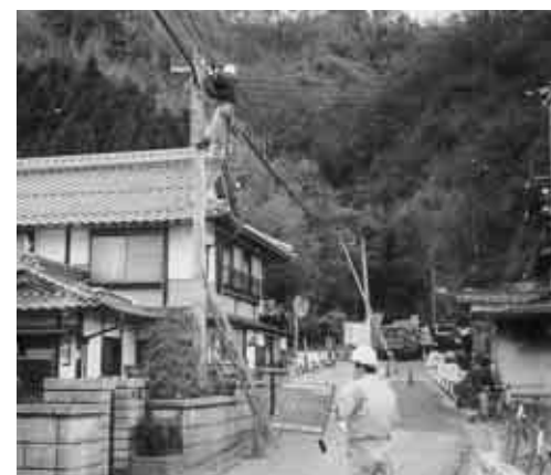
H11年当時のケーブルTV工事の様子
