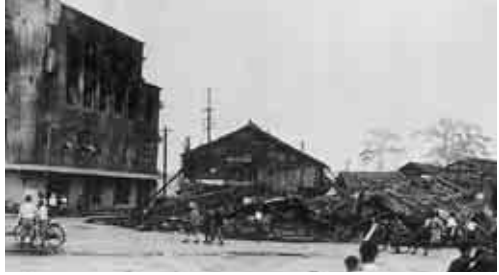
鳥取大震災の状況 (昭和18年)
