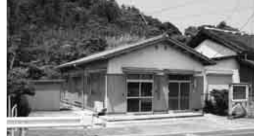
廃止され空家となっている駐在所 (気高町内)
