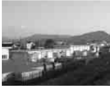
水道局叶水源地
