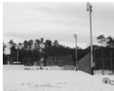
冬期は使用できない小学校の夜間照明
