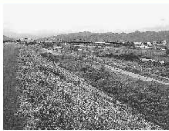
千代川の取水源地付近
