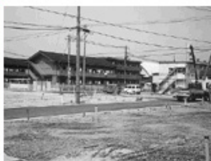
建設が進む学生向けアパート
