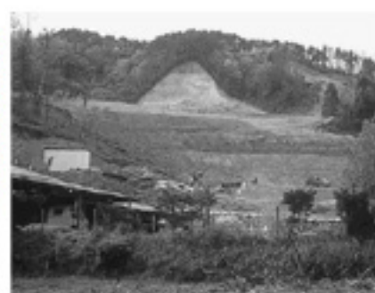
浄水場造成工事現場
