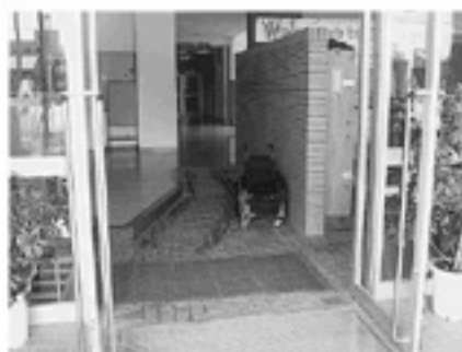
バリアフリー化された玄関(道義小学校)
