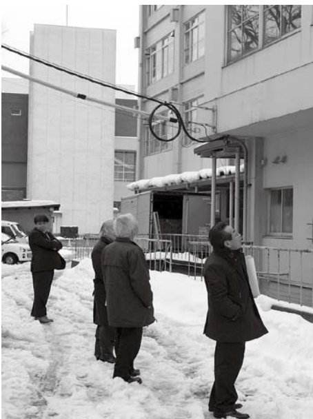
現本庁舎の現況調査の様子
