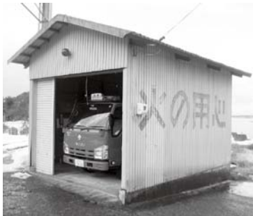
耐震対策が急がれる消防団の格納庫
