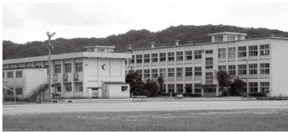
老朽化が進んでいる青谷中学校
