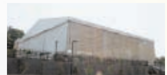
現在の大型仮設テント
