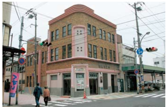
色鮮やかに復元されたビル上部の蛇腹とスクラッチタイル
