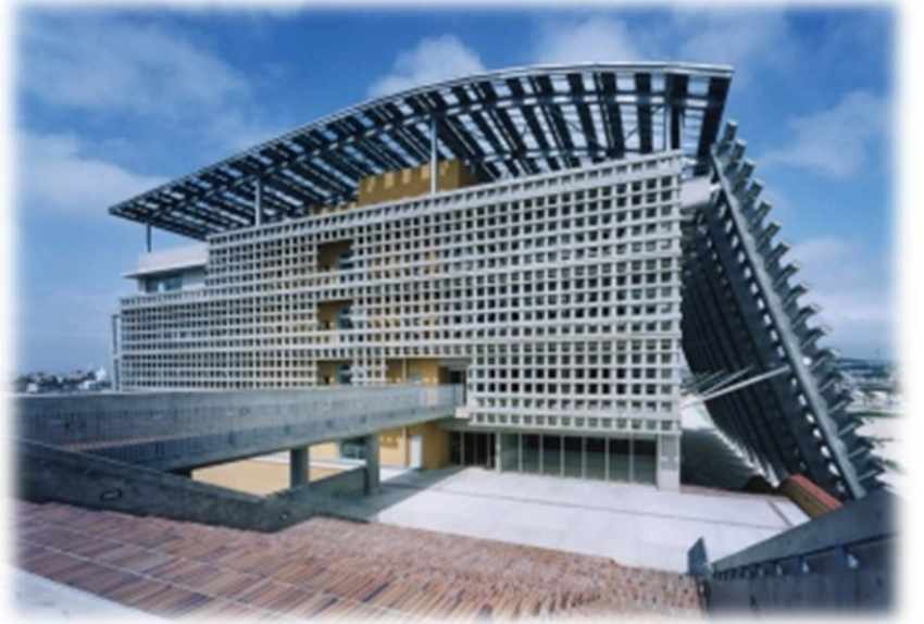
糸満市庁舎（平成14年3月完成）
