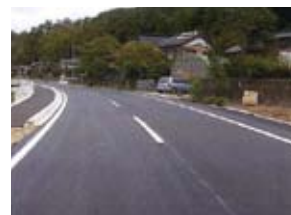
市道美歎線道路改良工事
