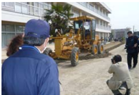
校庭の表土除去作業
