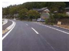
市道美歎線道路改良工事
