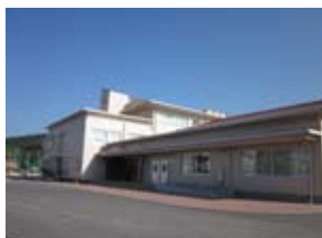
修立小学校校舎新築事業
