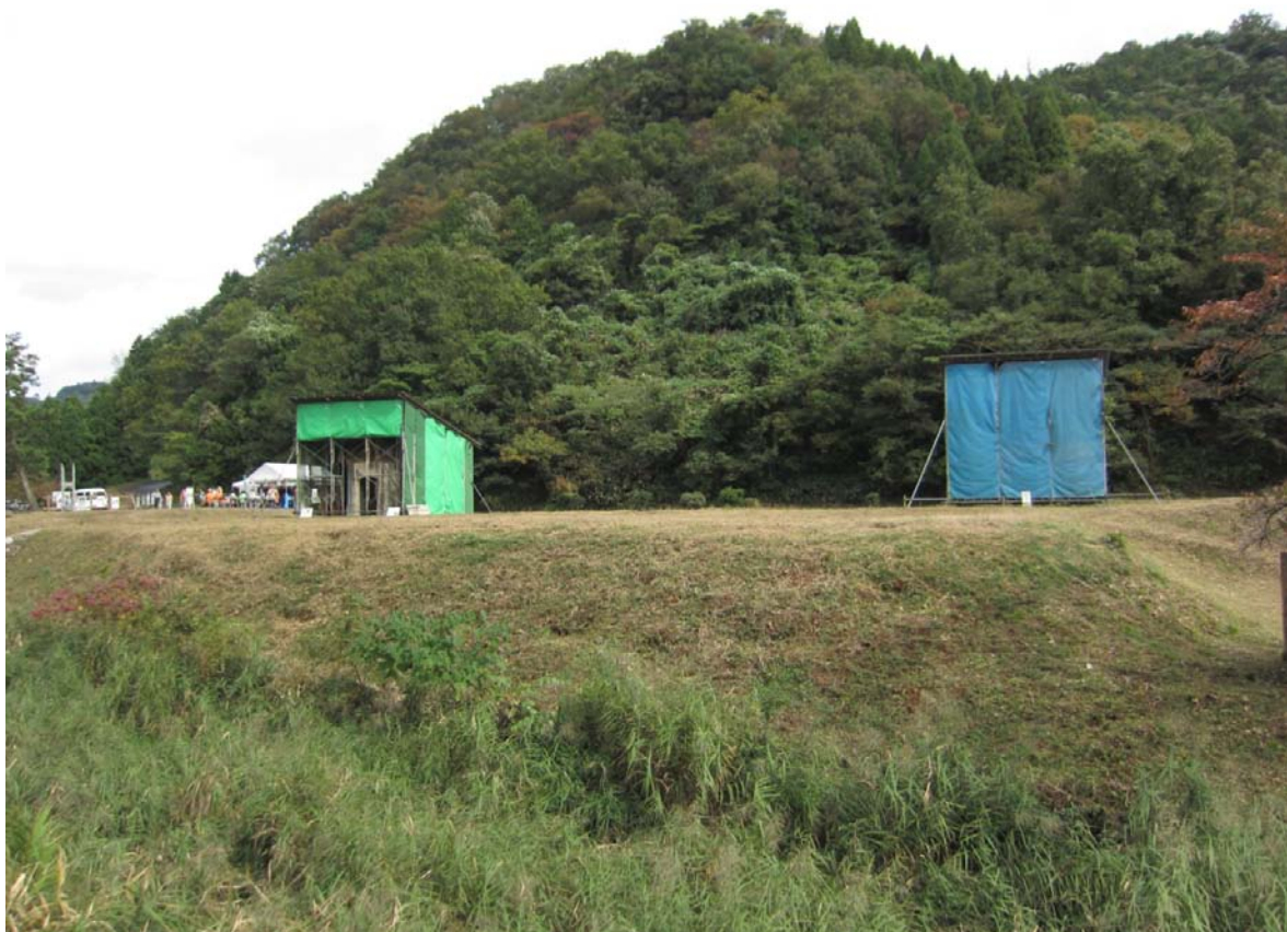
①旧美敷水源地水道施設特別公開 遠景(右端の覆屋から順に…2号ろ過池・1号ろ過池・公開用のテント)
