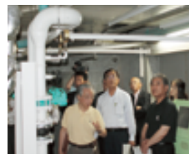
山本参考人と委員による現地調査 (市役所本庁舎地下) 6月14日
