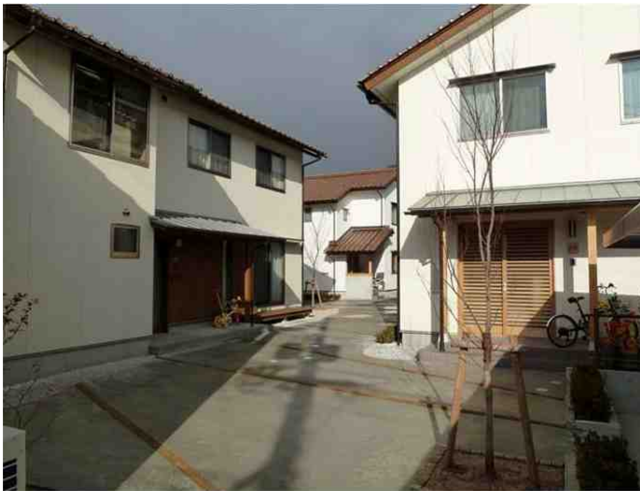
エントランスより敷地内通路をみる（南→北）
