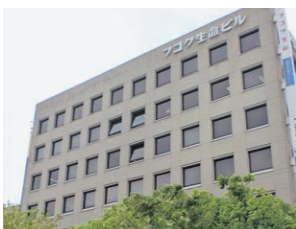
本社オフィスビル
