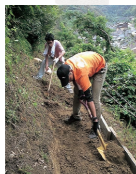
三尾地区の遊歩道整備
