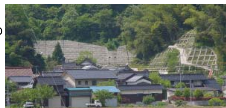
砂防事業による土砂災害防止対策
