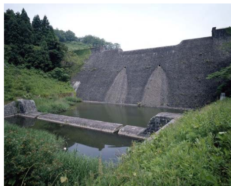
重要文化財旧美歎水源地水道施設（堰堤） 平成19年6月指定
