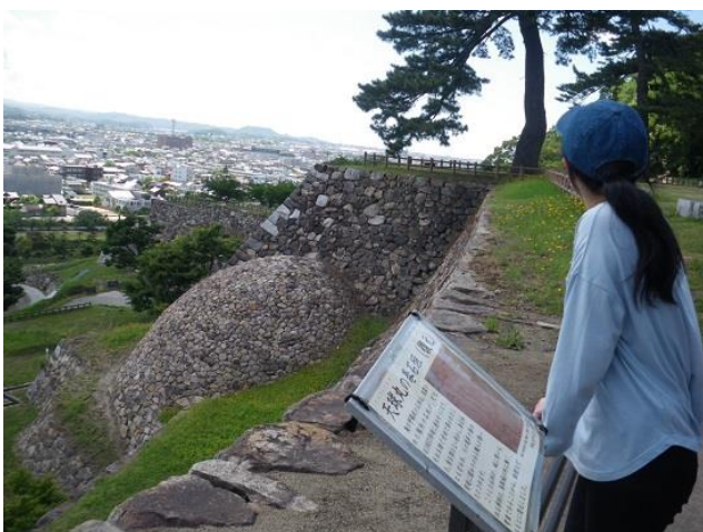
天球丸から望む鳥取市街地です。巻石垣は石垣の崩壊を防ぐ目的で作られたものです。
