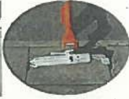
側溝ふたの手掛け部へアームの爪部を入れ、ふたをつかみます。
