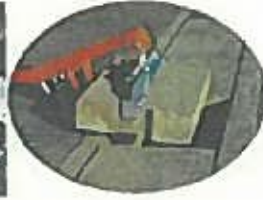
側溝ふたの手掛け部へアームの爪部を入れ、ふたをつかみます。
