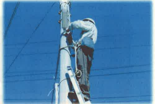
LED防犯灯の設置
