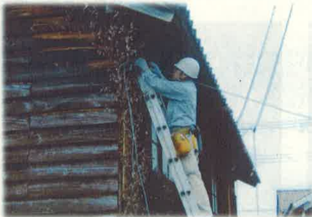
有線放送の改修
