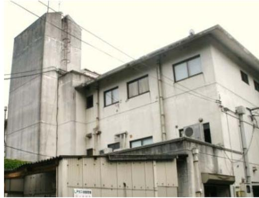
外壁の爆裂・剥落
