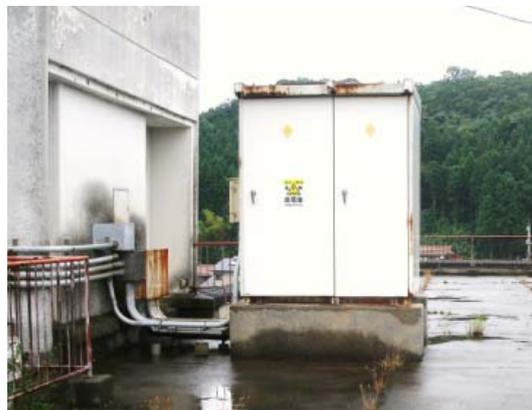
高圧受電設備の腐食
