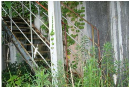
鉄骨階段の腐食
