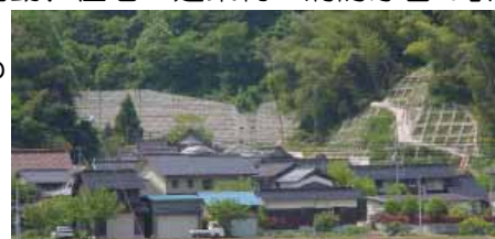
砂防事業による土砂災害防止対策
