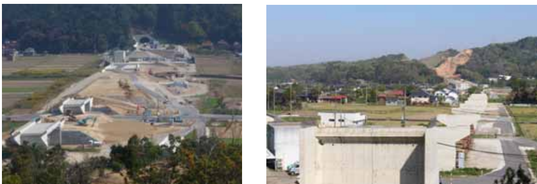
高速道路ネットワークの整備（山陰自動車道）
