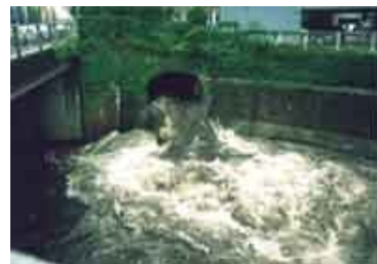
雨天時の放流状況
