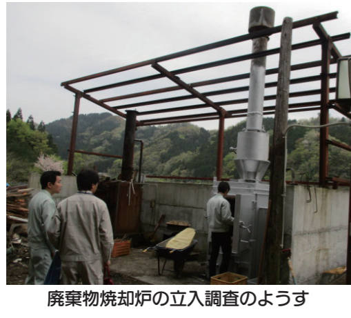
廃棄物焼却炉の立入調査の様子
