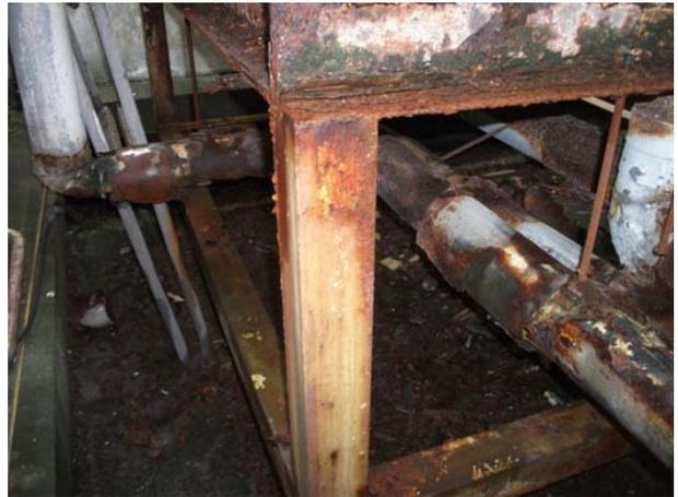
5 浴室棟 1:全自動洗浄ろ過機(BFD-1)、架台腐食あり
