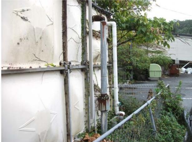
3 旅館棟:各水槽架台腐食有り、周囲配管、保温材劣化あり
