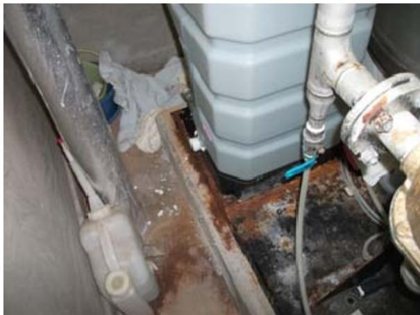
8 浴室棟 2:温泉加圧ポンプ(SP-2)、腐食あり、周囲配管より漏水
