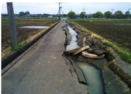
図 19 汚水幹線の路面陥没 (出所：国土技術政策総合研究所資料)
