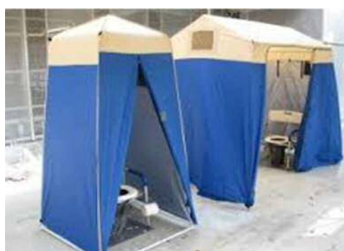
図 20 マンホールトイレ
