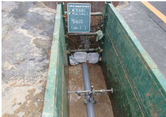
図 24 汚水管の敷設
