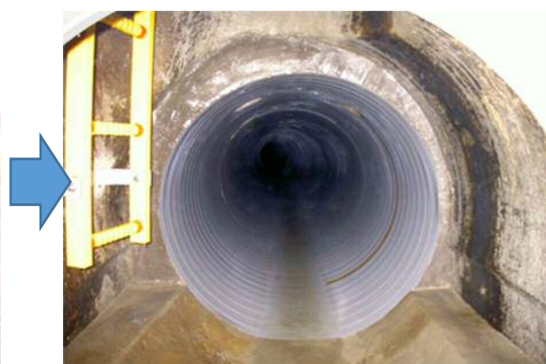
図 30 管更生実施後
