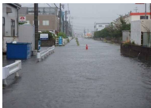
図18 大雨時の冠水状況
