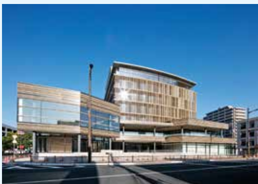
国道53号から見た新本庁舎
