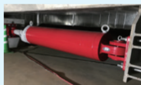
地震の揺れを吸収する免震オイルダンパー
