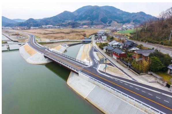
写真3: 箭溪川（江川）との合流部の改修状況
