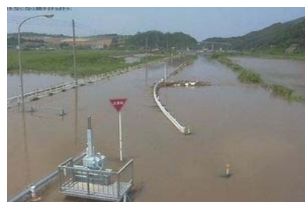
写真33: 以前の塩見川水害状況
